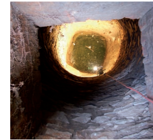
Blick in den Schacht
