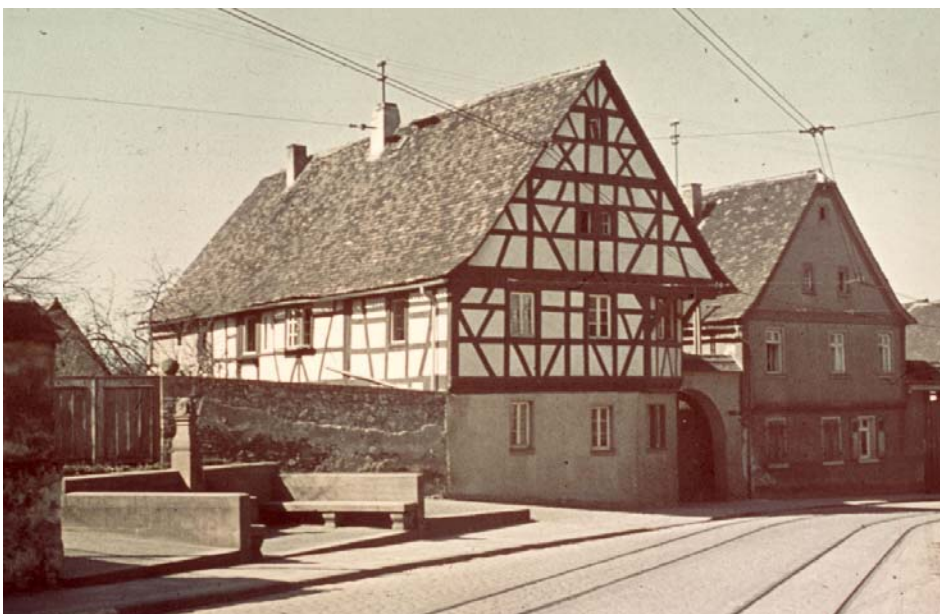
Fachwerkhaus 1577 am Kirchenaufgang mit Jubiläumsbrunnen
