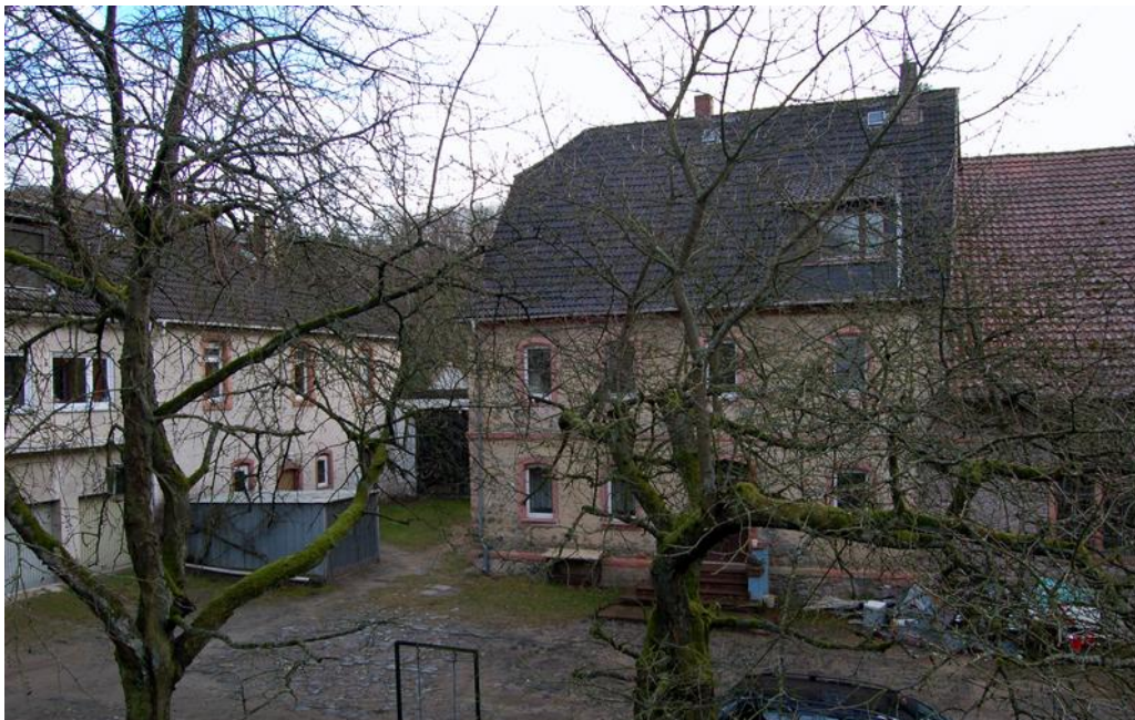
Innenhof der Koppenmühle; sanierungsbedürftiger Zustand 2008
